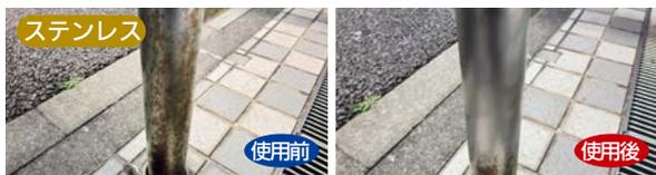
ステンレスの汚れ:サビ除去後表面に不働態被膜が生成されるので新品の状態に戻ります。
